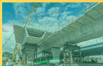
Routes, Industries des matériaux et fondations
