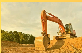
Terrassement, Démolition et transport
